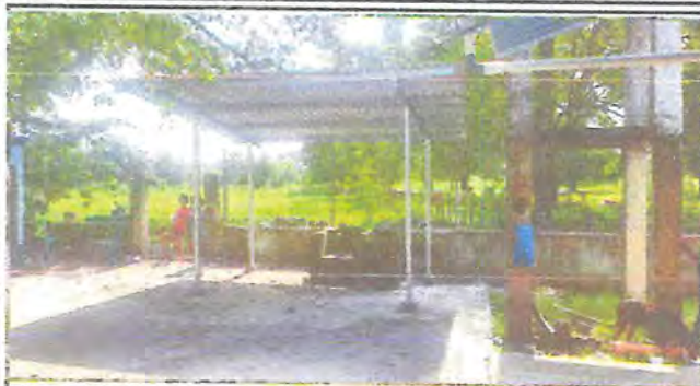
Foto 7: Estructura y techo de galera
